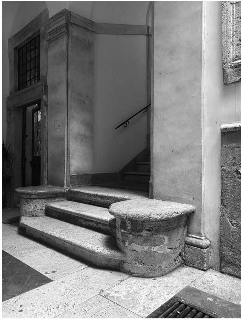
FIG. 18. Particolare della scala di palazzo Tancredi-Cisterna (qui attribuita ad A. da Sangallo il Giovane), quarto decennio del XVI secolo.
