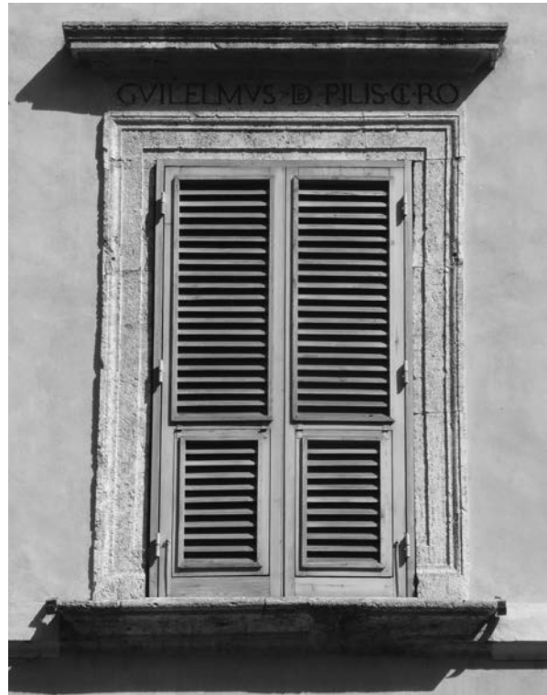
FIG. 9. Finestra del secondo piano di palazzo Tancredi-Cisterna (qui attribuita ad A. da Sangallo il Giovane), quarto decennio del XVI secolo.
